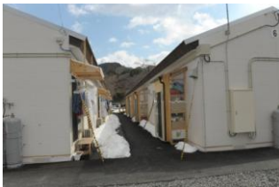
安渡保育所前の仮設住宅
