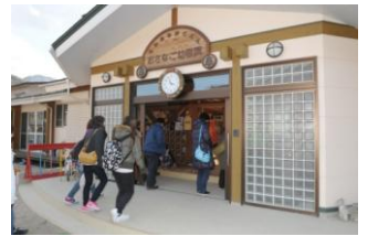
復旧したおさなご幼稚園園舎
