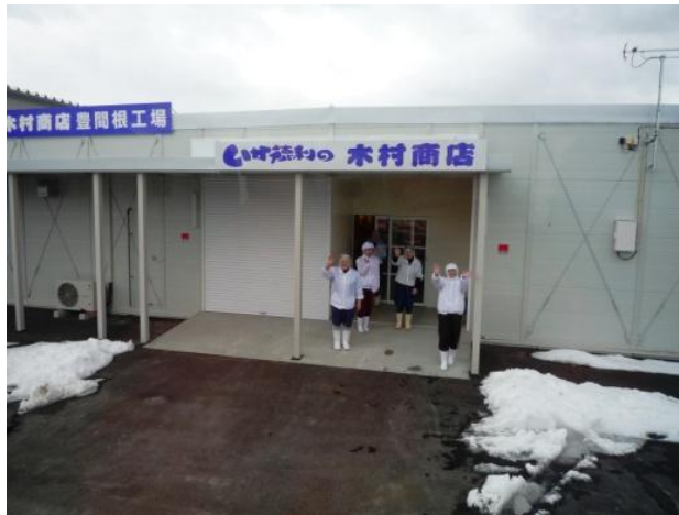
新設移転の木村商店豊間根工場
