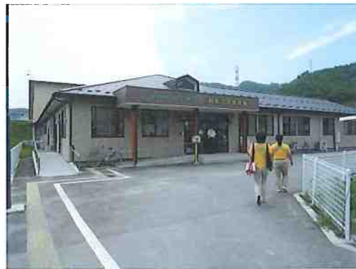
大槌保育園被災園舎復旧工事中（軒下まで被災）
