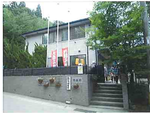
みどり幼稚園仮設園舎 (高校宿舎借用中)
