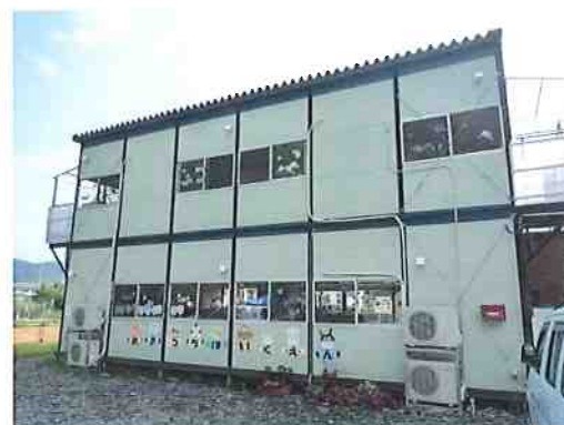
大槌保育園仮設園舎（ユニセフ支援）
